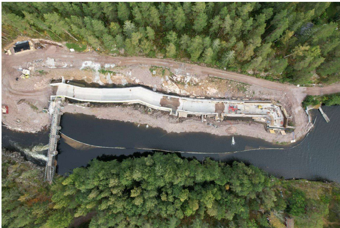
Bild från byggandet av den nya fiskvägen i Laxberg 2024. Foto: Jönköpings Fiskeribiologi AB
