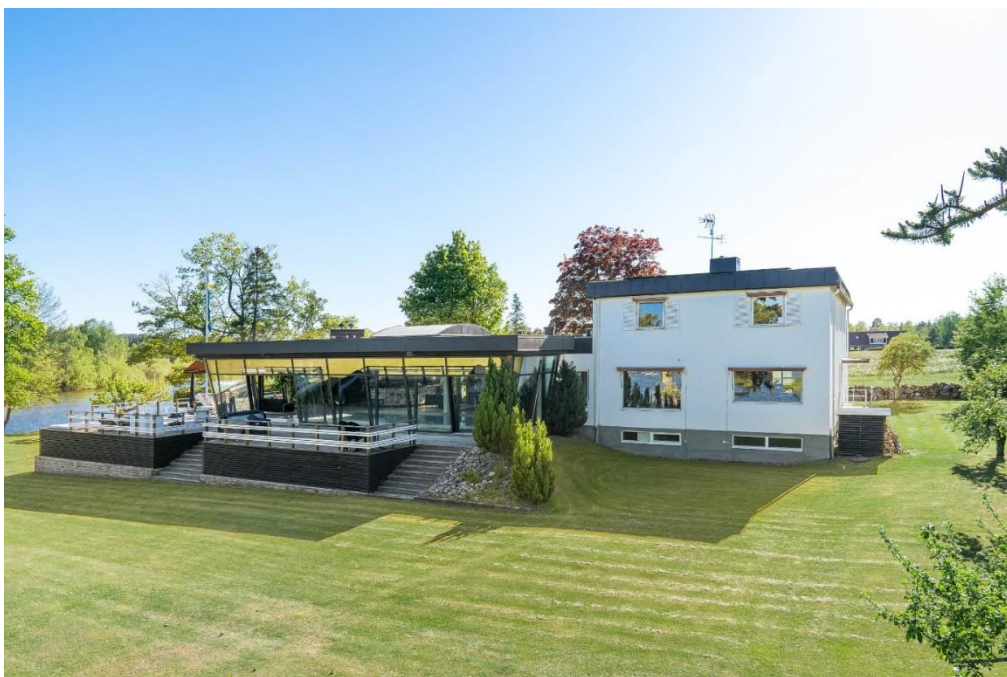
Befintlig bostadsbebyggelse på Norraby 3:3 sett från öster.
