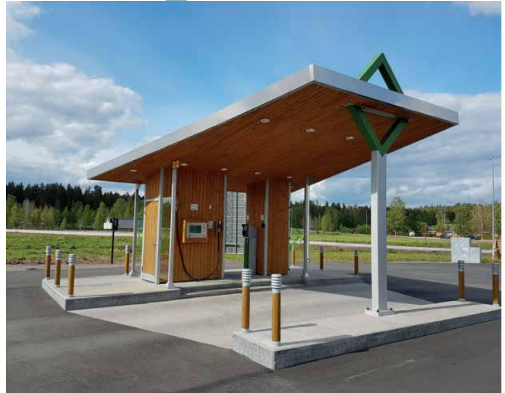
Foto Hagelrums Biogas
